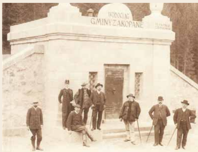
Wodociąg Gminy Zakopane
